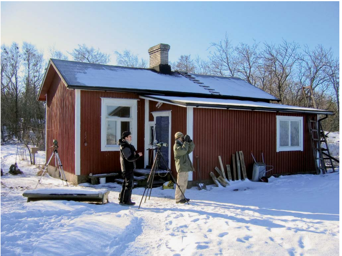
1930-luvulla rakennettu asemarakennus toimii tukikohtana ympärivuoden vieraileville retkeilijöille. Aseman kunnostus on toistaiseksi tapahtunut pitkälti harrastuspohjalta ja aseman huoltamiseen tarvittaisiin ammattimainen ote. © Paavo Junttila, helmikuu.
